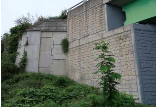
패널식 보강토옹벽 상태양호
