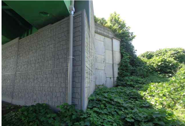
패널식 보강토옹벽 상태양호
